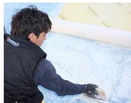
**2.** Colocar la lámina POOL120 completamente adherida al antiguo revestimiento con cemento cola C2 flexible (preferiblemente S1 o S2).
