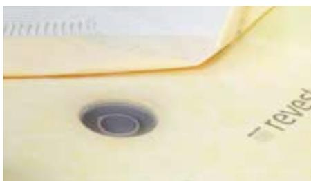
4. Extender la lámina sobre el cemento cola.
