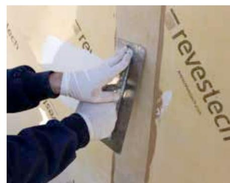
Asegurarnos de que toda la lámina esté perfectamente adherida al soporte y no haya ninguna burbuja de aire por pequeña que sea, a fin de evitar desprendimientos o abombamientos futuros. Después esperar a que seque el adhesivo.
