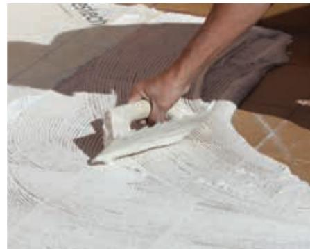
**3.** Aplicar cemento cola C2 sobre el soporte. Fijar bien la lámina al soporte, asegurándonos de eliminar con la llana todas las posibles bolsas de aire que se puedan generar.
