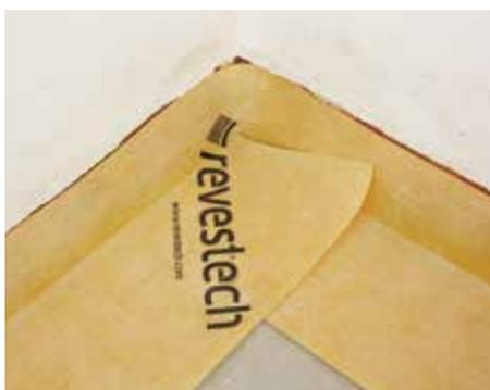
**7.** Realizar las uniones con los paramentos verticales con Banda DRY80 solapando con un mínimo de 10 cm sobre la lámina ACU200.
