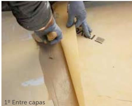
**5.** Realizar las uniones entre láminas con adhesivo Seal Plus. Poner una primera capa entre láminas (1º).
