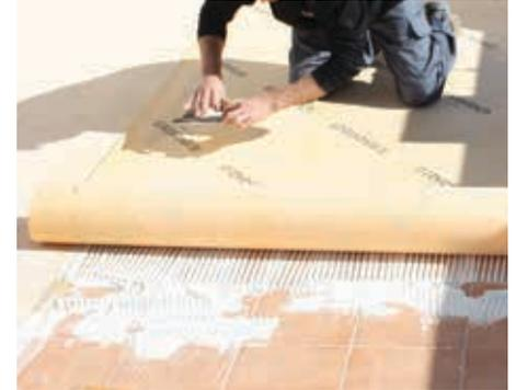
**3.** Aplicar cemento cola C2 sobre el pavimento antiguo. Fijar bien la lámina al soporte, asegurándonos de eliminar con la llana, todas las posibles bolsas de aire que se puedan generar.
