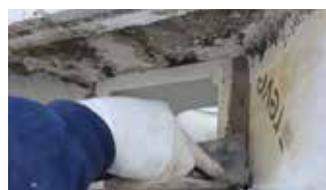
Los encuentros con el plástico unirlos con un adhesivo bicomponente poliuretánico o epoxi. Aplicar con una espátula.
