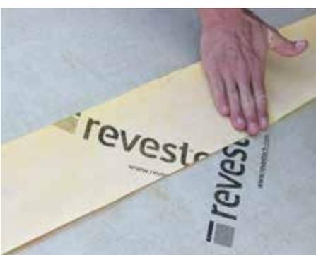
**5.** Realizar las uniones entre láminas con Banda DRY50 13 y adhesivo SEAL PLUS.
