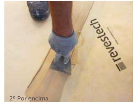
**6.** Después rematar la junta por encima con Seal Plus (2º): doble sellado.
