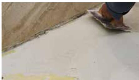
8. Extender cemento cola con la llana de 4 mm sobre la lámina.
