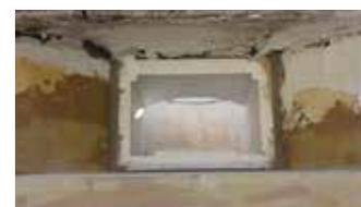
Acabar de sellar las juntas con la banda DRY50 13 y pegarlo todo con adhesivo Seal Plus.
