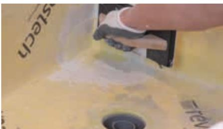
7. Formar las esquinas plegando la lámina. Para un acabado perfecto utilizar las piezas premoldeadas Cornerin y Cornerout.
