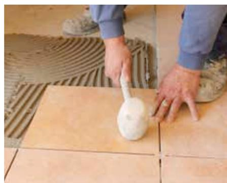
**9.** Colocar el pavimento directamente con cemento cola C2 y fijar el rodapié.
