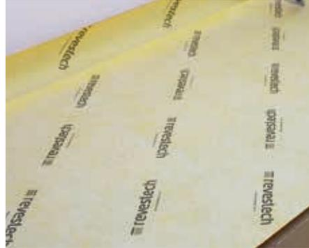
**2.** Replanteo, medición, extender la lámina y cortar los paños.
