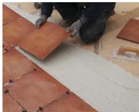
**8.** Colocar el pavimento directamente con cemento cola C2 y fijar el rodapié.
