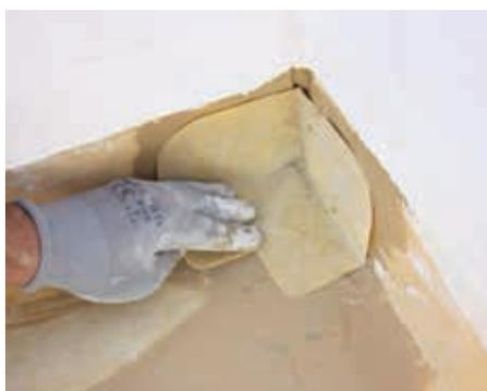
**8.** Utilizar los diferentes complementos DRY80 Cornerin, Cornerout y SUMI 56 para resolver los puntos singulares.
