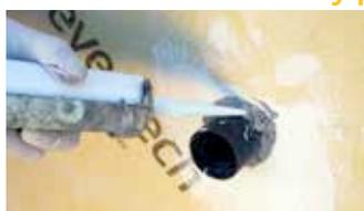
Rellenar con un cordón de adhesivo bicomponente poliuretánico o epoxi, para la fijación de la lámina al pvc, polipropileno, etc.
